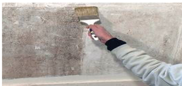
Рис. 3. Нанесение эмали на поверхность бетона
